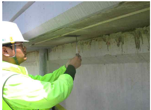
탄산화깊이 측정 현황
